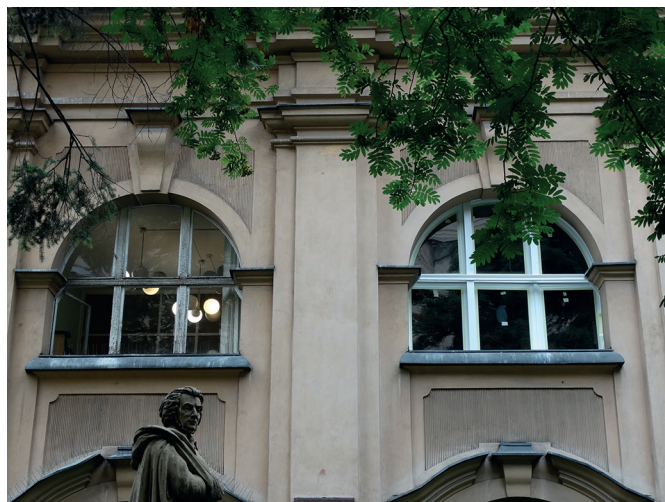
Okna przed renowacją i po renowacji. Fot. A. Kucharska
